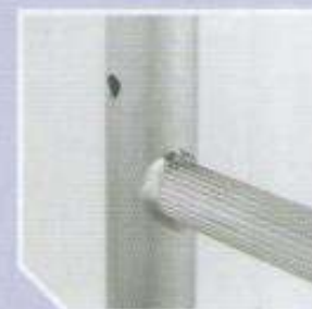
Сварка по периметру.
