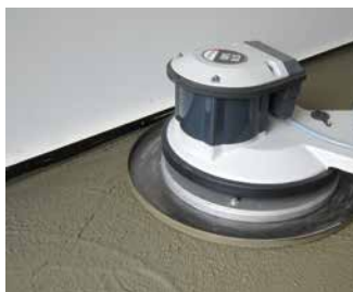
Заглаживание бесшовного пола
