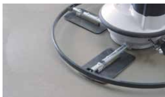
Заглаживание с помощью лопастей
