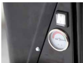
контроль избыточного давления
