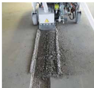
Осциллирующее фрезерование при небольшой рабочей массе
