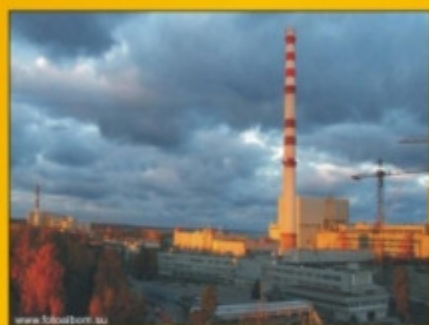
Ленинградская АЭС, г. Сосновый Бор
