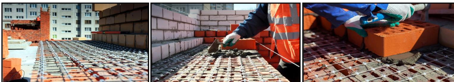
Композитная базальтопластиковая сетка имеет ряд преимуществ по сравнению с традиционной стальной сеткой ВР-1.
