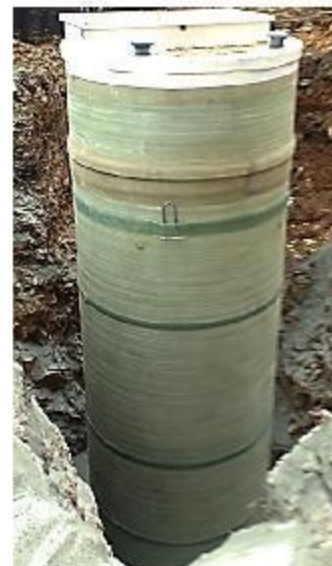
КНС в корпусе из стеклопластика
