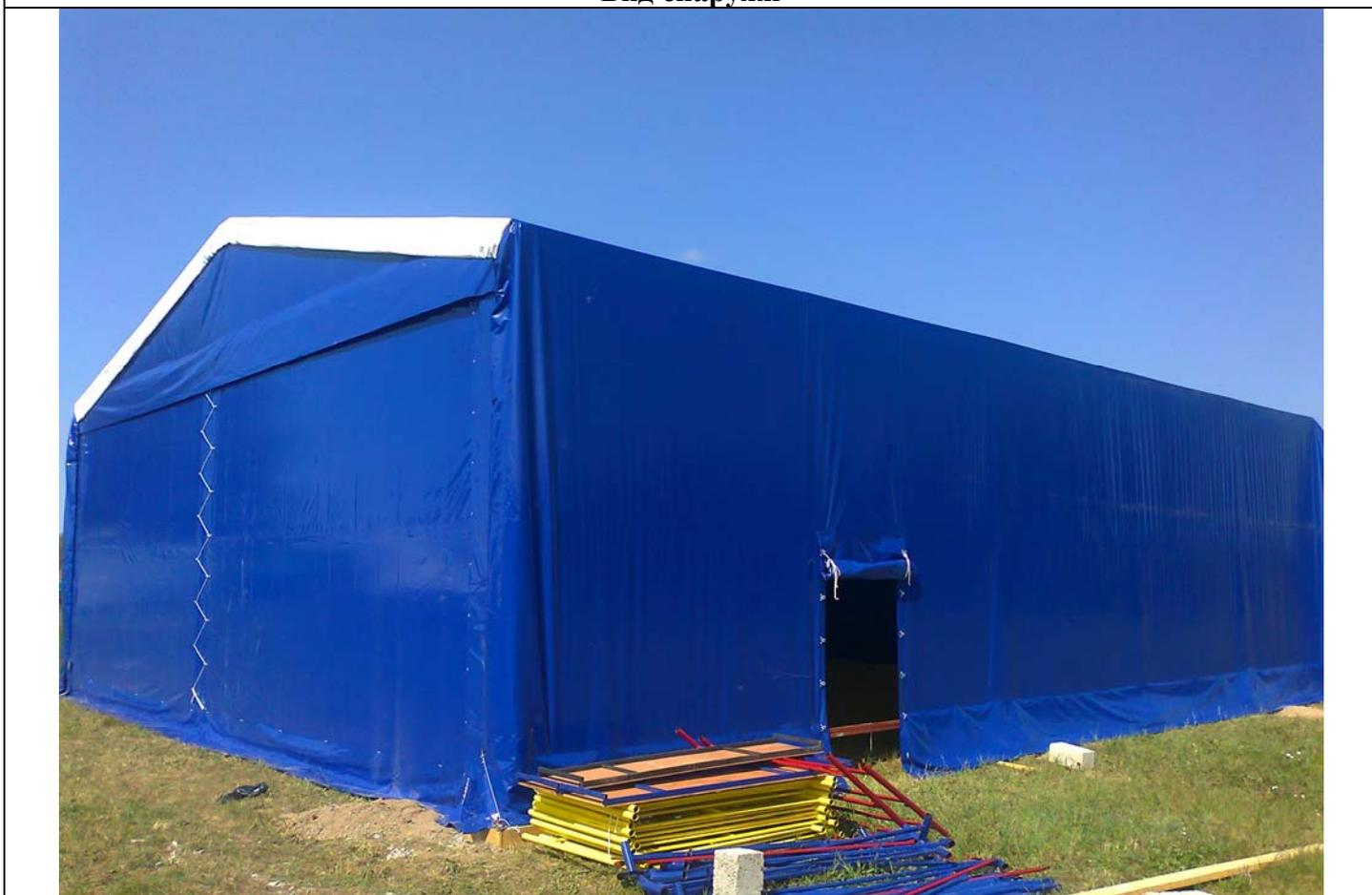
Каркасно-тентовый авиационный ангар под вертолеты со сдвижными тентовым пологом размерами **13x13x4,5 (169 м2)** изготовлен ЗАО ВК «Аэросоюз».
