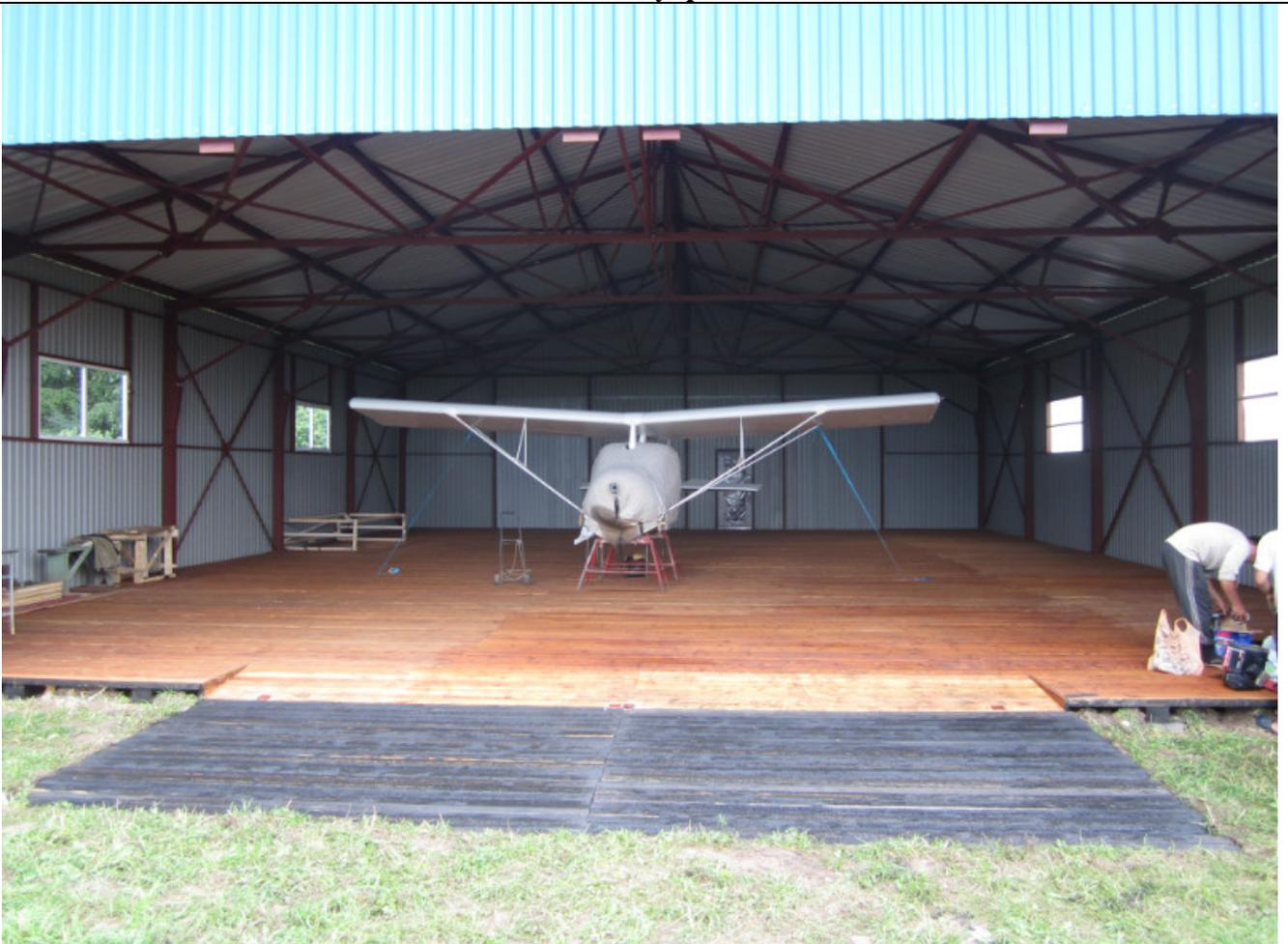
Тентовый авиационный ангар с подъемным полом размерами **20x15x4,2м (300м<sup>2</sup>)** с полом.
